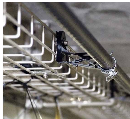
Das Strahlerkabel wurde mittels CLIC SKH auf Gittertrassen im Tunnel montiert.
